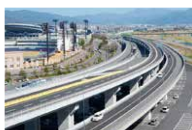
整備が進む松山外環状道路
