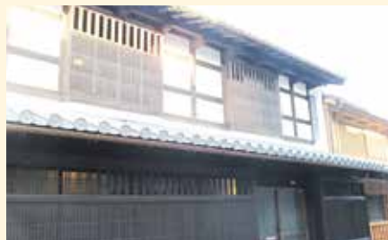
補助金を活用して整備された建物
