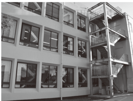
耐震化された支所と津波対策用の非常階段
