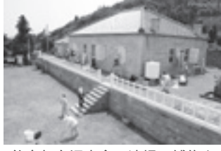
釣島灯台旧官舎の清掃・補修をするサポーターら
