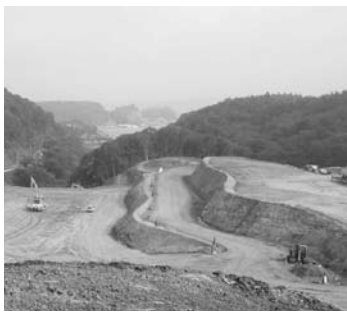
造成工事中の野蒜地区
