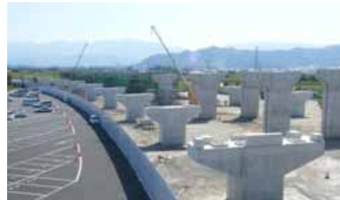
図 6.2.6 松山外環状道路 （工事の様子）
