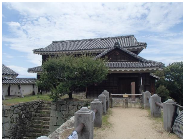
図 6-28 建造物に隣接する植栽木
