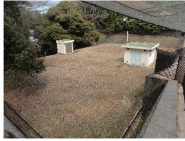
水道設備（東雲配水池）
