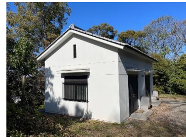
電気設備（電気室）
