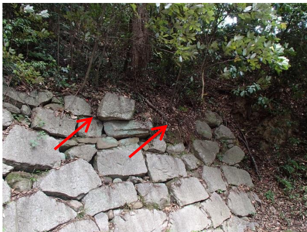
図 3-48 天端石付近に生育する樹木の根系による石垣の孕み、石垣の落下跡
