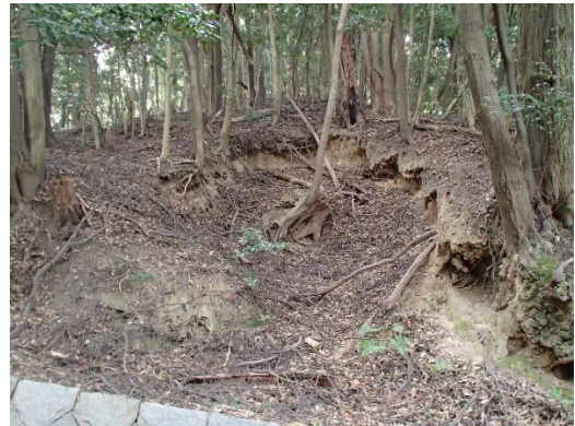
林内の小崩壊地
