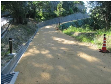
緊急車両用道路
