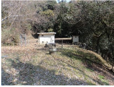
水道設備（城西配水池）
