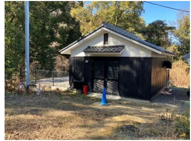
消火設備（ポンプ室・水槽）
