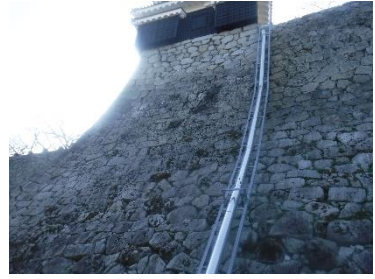
排水設備（排水管）
