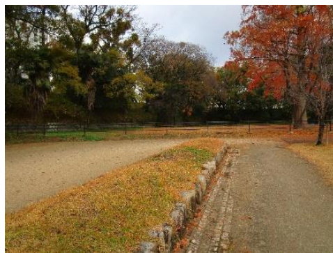
第1期整備で立体表示した馬場土手と側溝
