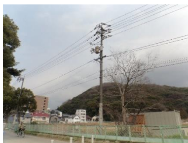
現状（三之丸御殿西側）
