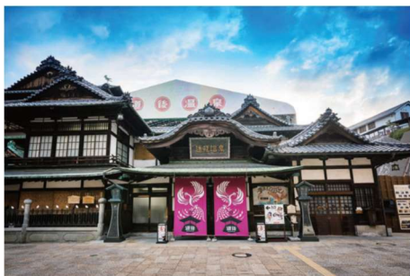
工事着工後の道後温泉本館
