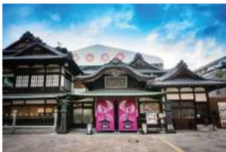
工事着工後の道後温泉本館
