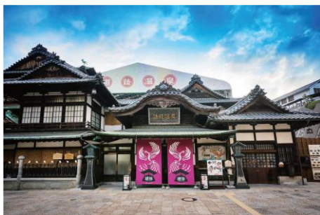
工事着工後の道後温泉本館
