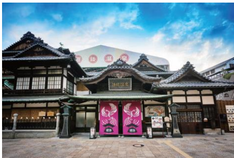
工事着工後の道後温泉本館
