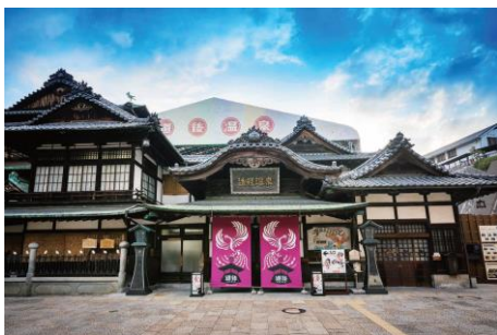
工事着工後の道後温泉本館
