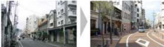
ロープウェー街整備前後の状況（左：整備前、右：整備後）
