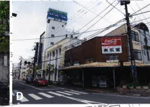
D 銀天街北口付近の木造建物
