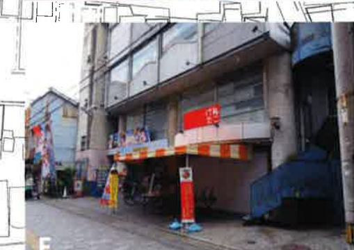
F 鉄筋コンクリート造の劇場
