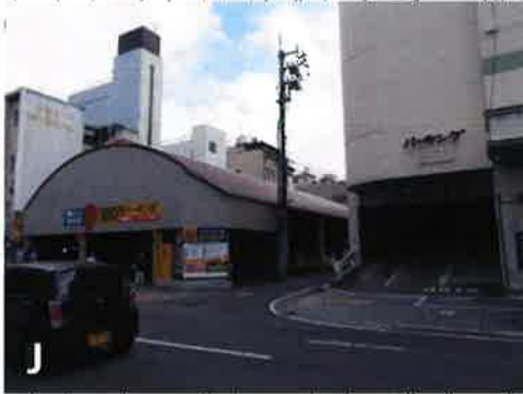
J 鉄骨造の駐車場
