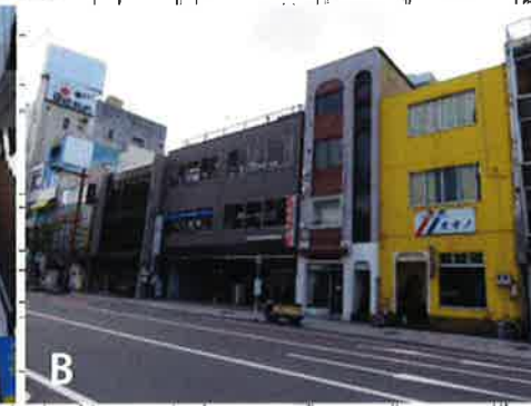
B 千舟町通り沿いは、鉄筋コンクリート造が多い。
