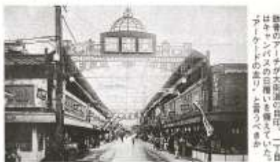
>昭和初期：鉄骨アーチ+すずらん灯
