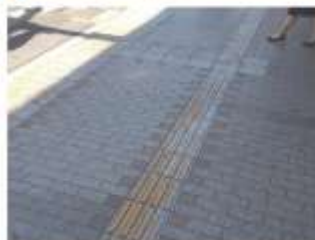
点字ブロックの劣化
