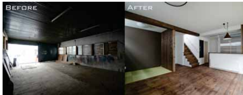
木造民家をリノベーションした例
