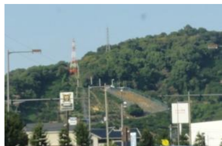
～岩子山トンネル(西方向)～
