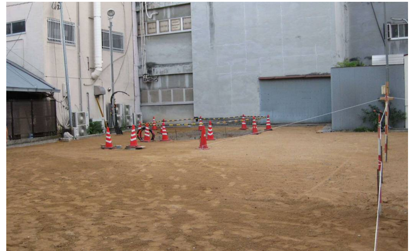
写真：広場（芝生広場）の工事の様子②
