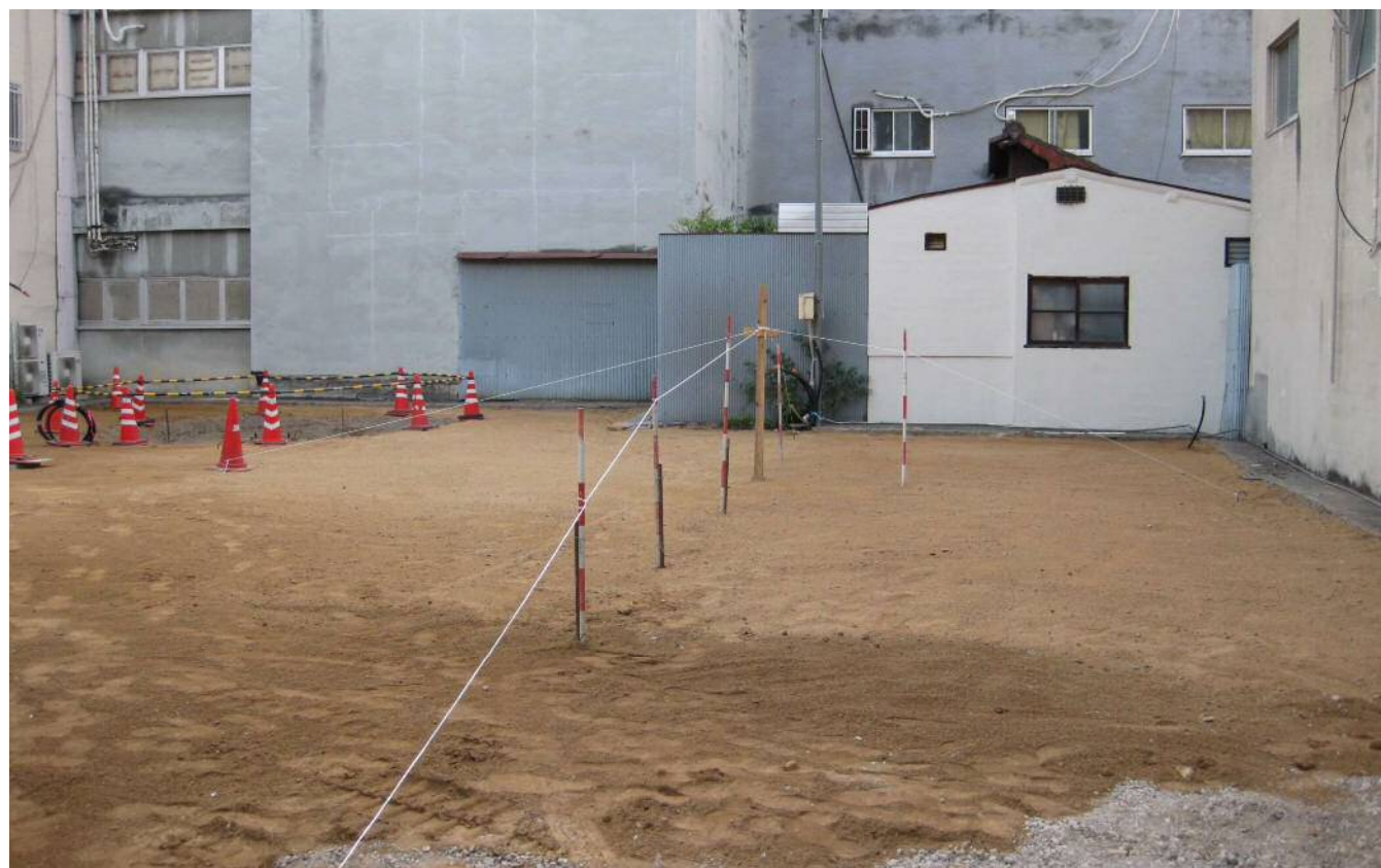
写真：広場（芝生広場）の工事の様子①
