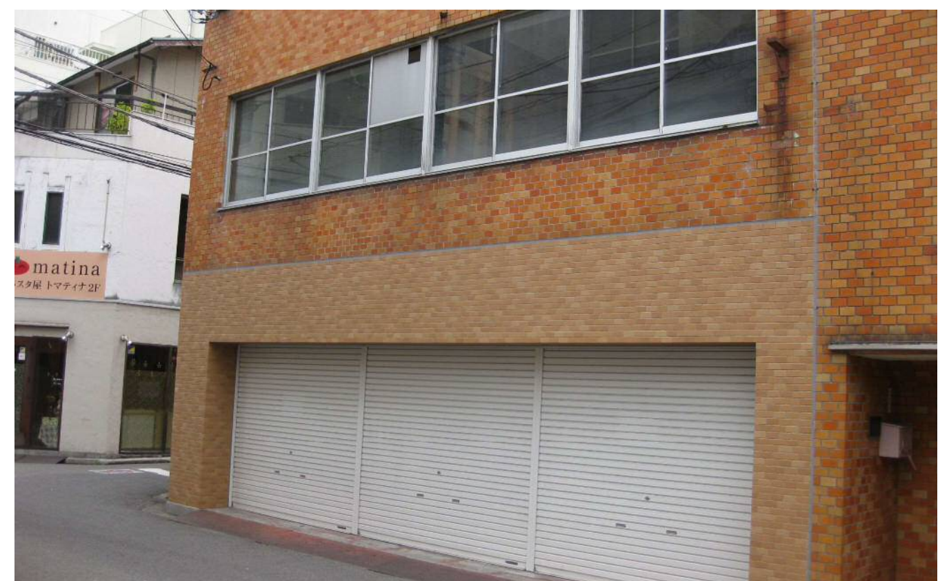
写真：建物（多目的スペース）の様子
