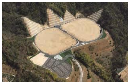
北条スポーツセンター
