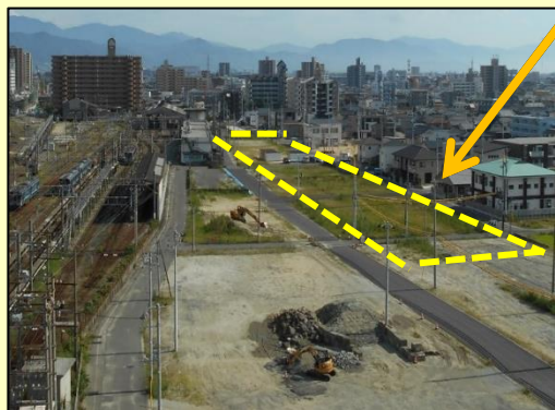
(予定) 宅地造成工事 (5、10街区)
