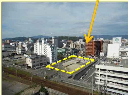
宅地造成工事 (25街区)
