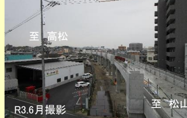
（高架区間：辻踏切付近の様子）
