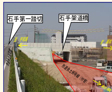
【市道付替工事（保免）進捗状況】
