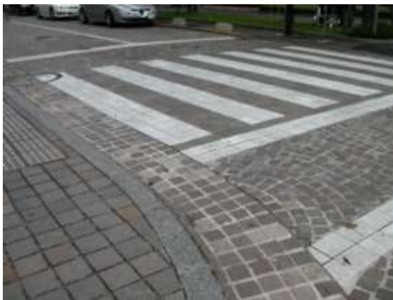
歩道の段差を解消した横断部（東京都千代田区）
