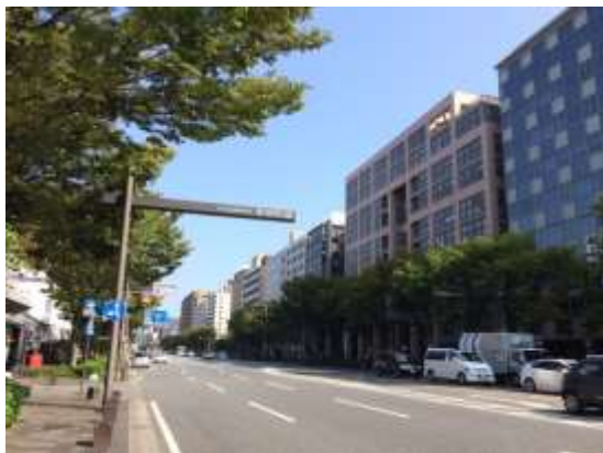
シンボルロードとして景観の調和が図られた街路 (京都市)
