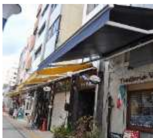
日よけテントを設置した例
