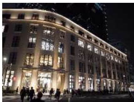
建物のデザインを生かしたライトアップ
