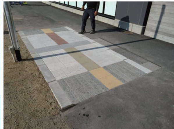
図 3-2-2 試験施工写真
