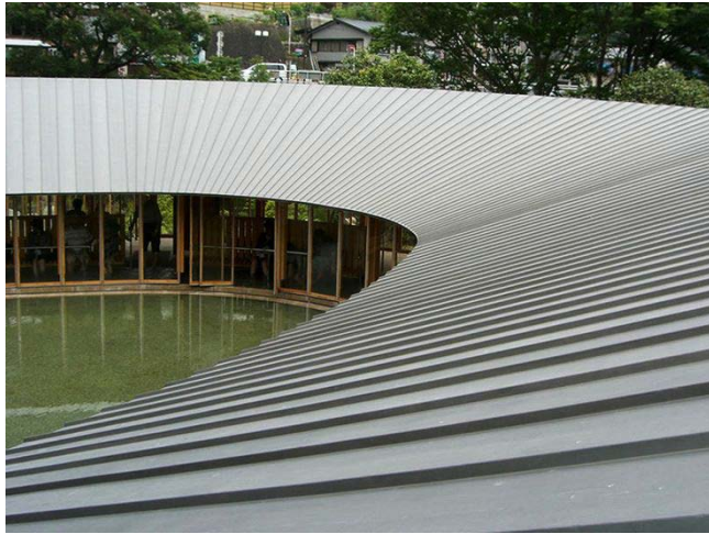
図 3-4 亜鉛合金板を用いた縦ハゼ葺きの事例 出典：新星商事 HP
