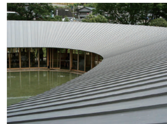
図3-13 亜鉛合金板を用いた縦ハゼ葺きの事例 出典：新皇商事 HP©SHINSEISHOJI CO.,LTD.
