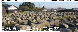
積み直し工事を待つ石材
