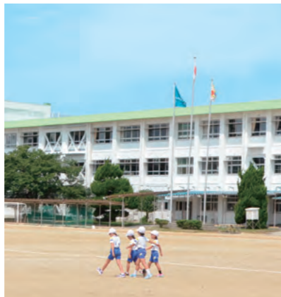
耐震化された小学校校舎
