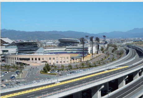
松山外環状道路整備
