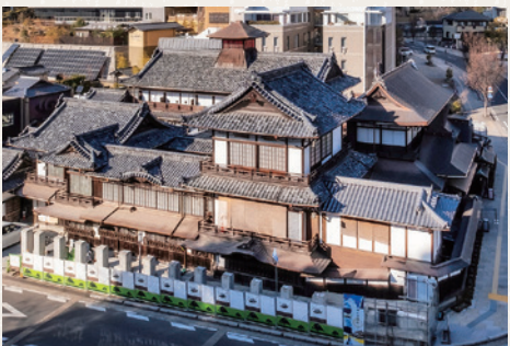
道後温泉本館保存修理工事
