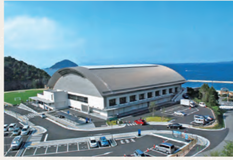
北条スポーツセンター整備完了(平成23年)
