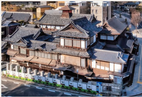
道後温泉本館保存修理工事
