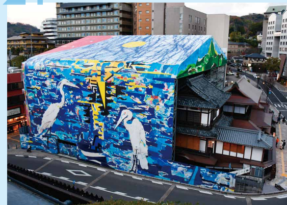
●道後温泉本館素屋根テント膜作品・ 「熱景／NETSU-KEI」
