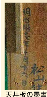
天井板の墨書
