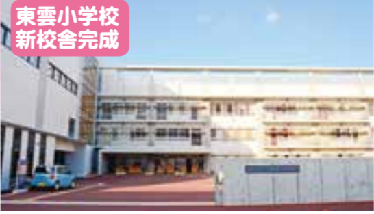
東雲小学校新校舎完成 昭和20年代の建築で、老朽化や耐震性の対応が必要であった東雲小学校の校舎を建て替えました。児童数の減少から規模を適正化し、市教育研修センターも整備しました。
