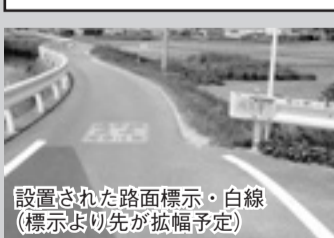
設置された路面標示・白線(標示より先が拡幅予定)
