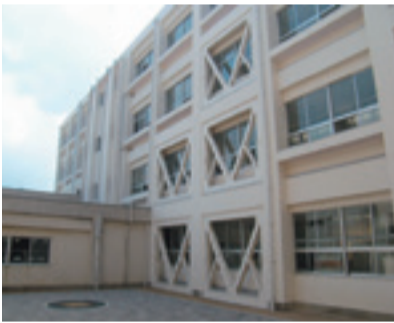
耐震化された校舎
