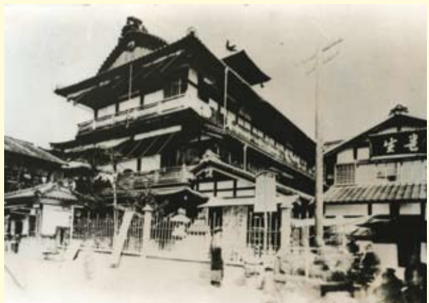
改築当時の道後温泉本館
