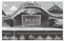
日本三古湯のひとつ 道後温泉本館
