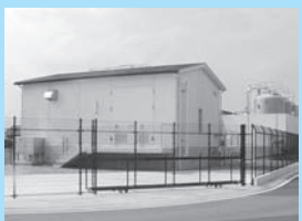
日量4,500立方メートルの水量が確保できる城北地区の深井戸
