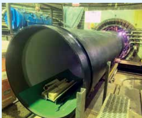
市之井手系導水管の布設替およびシールド工事
