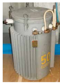
トランス(変圧器)
