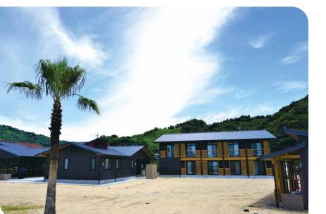
令和2年7月に、中島に新しい交流拠点「はしふるテラス姫ヶ浜」がオープン
