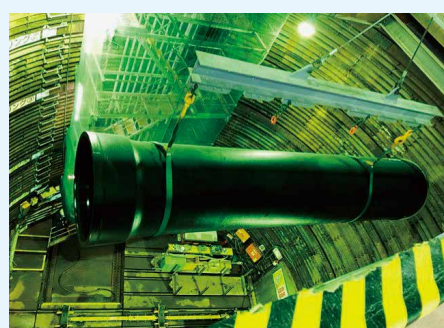
市之井手系導水管の布設替およびシールド工事
