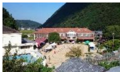
翠小学校の木造校舎
