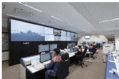
松山圏域消防指令センター
