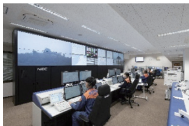
松山圏域消防指令センター
