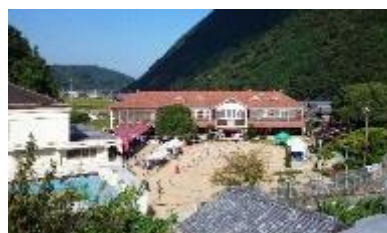
翠小学校の木造校舎
