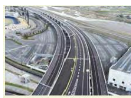
松山外環状道路空港線の側道部
